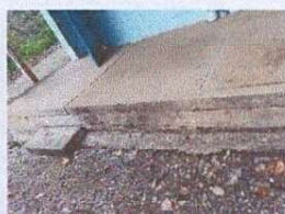
Foto 3: Reparación de gradas en mal estado
