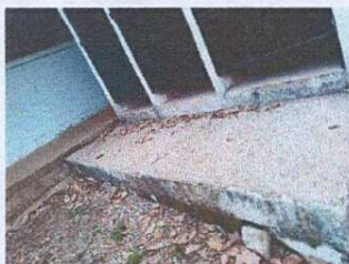
Foto 1: Reparación de gradas de concreto en mal estado sustitución de losa
