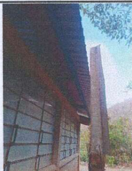
Foto 3: Sustrucción de Canales y bajadas de agua pluvial
