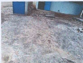
Foto 1: Sustrucción torta de concreto
